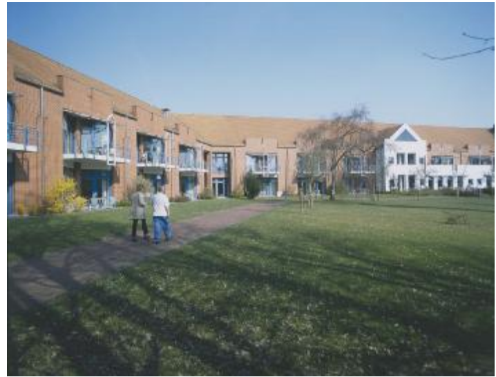
Sonderstation für Schwerverletzte Hachmühlen
