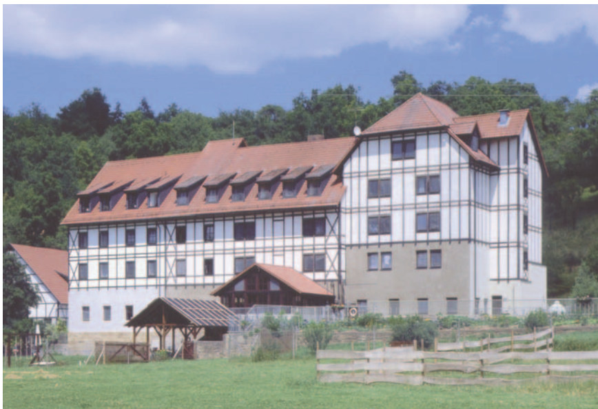
Klinik Neumühle, Rehabilitationsklinik für Drogenabhängige
