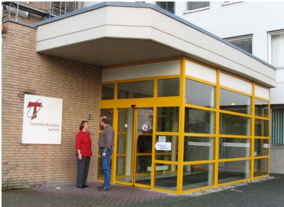
Franziskushospital Aachen • Haupteingang Morillengang
