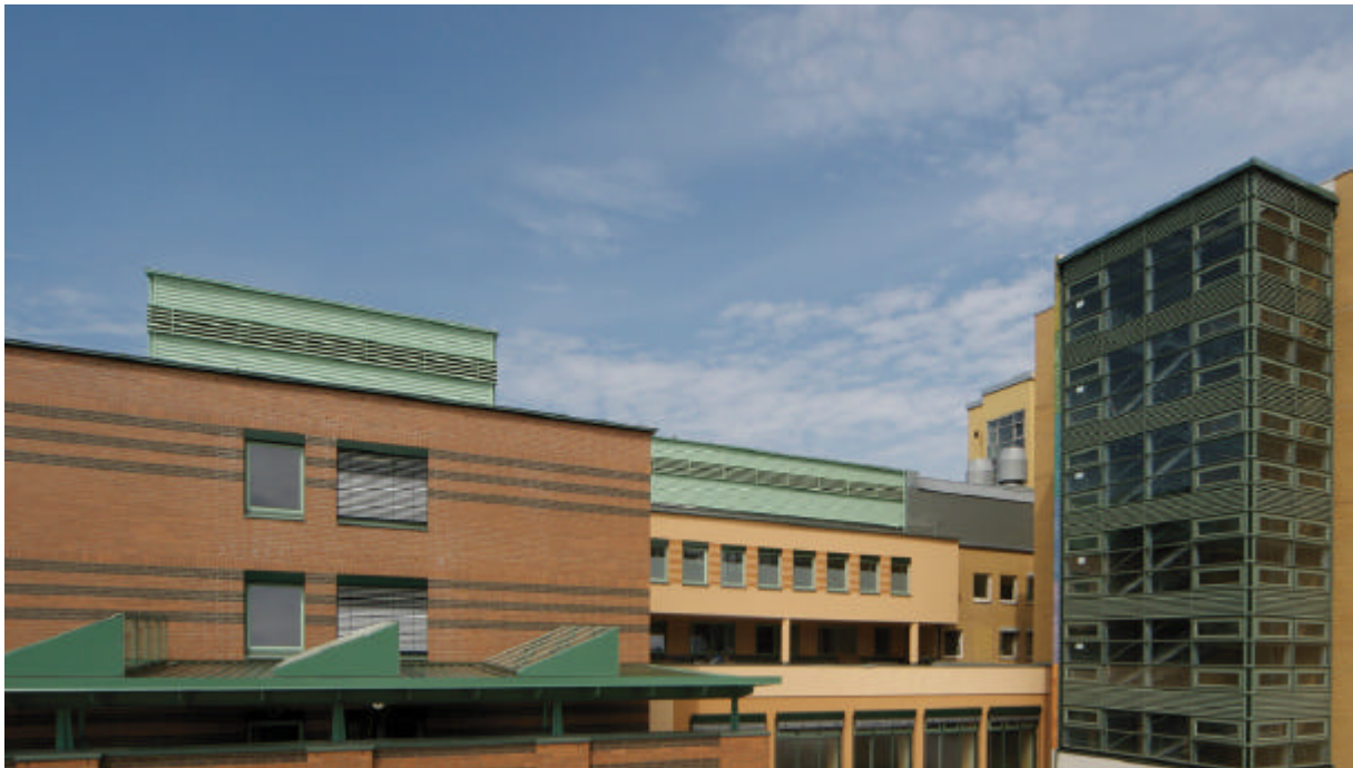
Abb.: Herzogin-Elisabeth-Hospital Braunschweig, Ausschnitt der Südfassade
