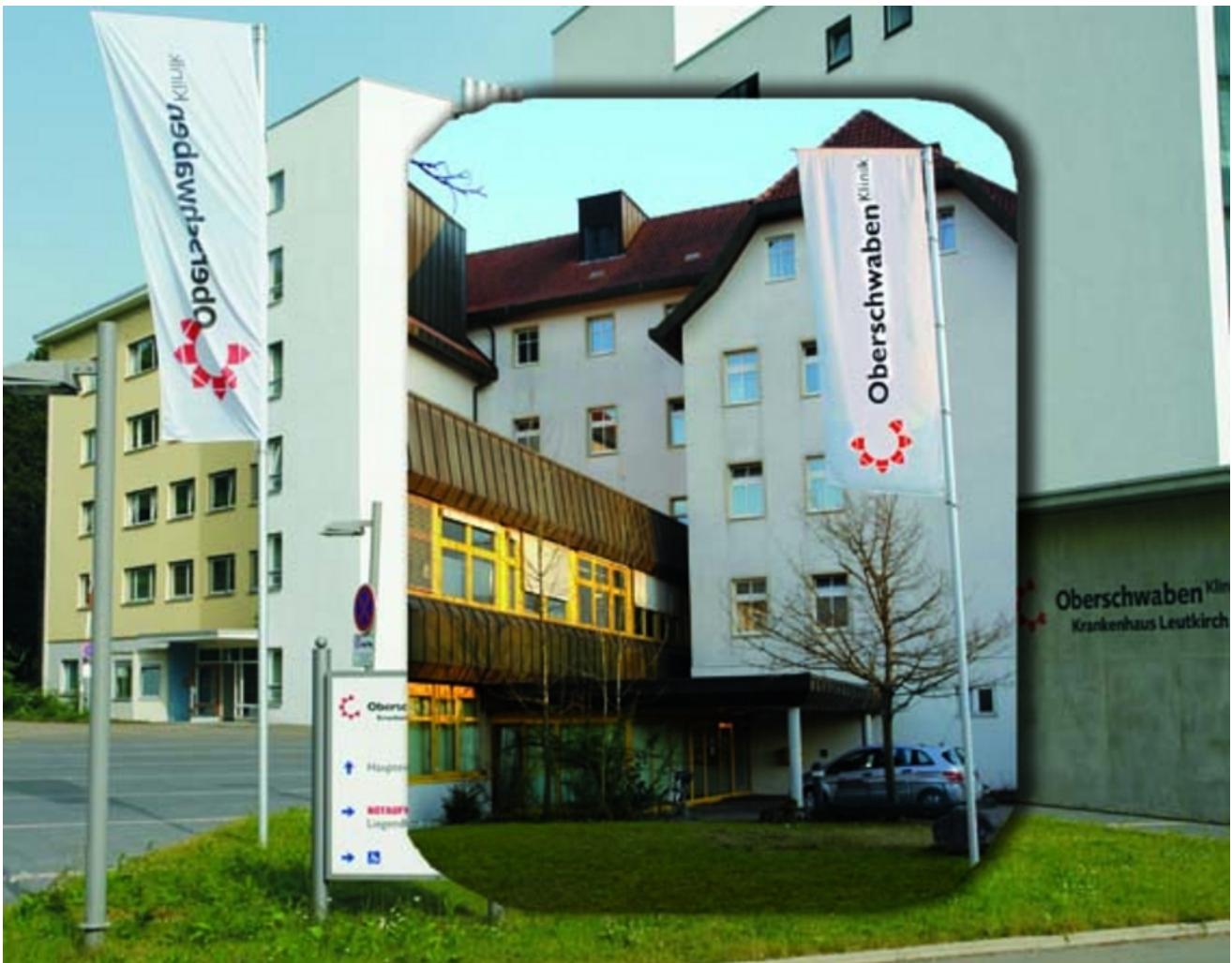
Abbildung: Die Krankenhäuser Isny und Leutkirch
