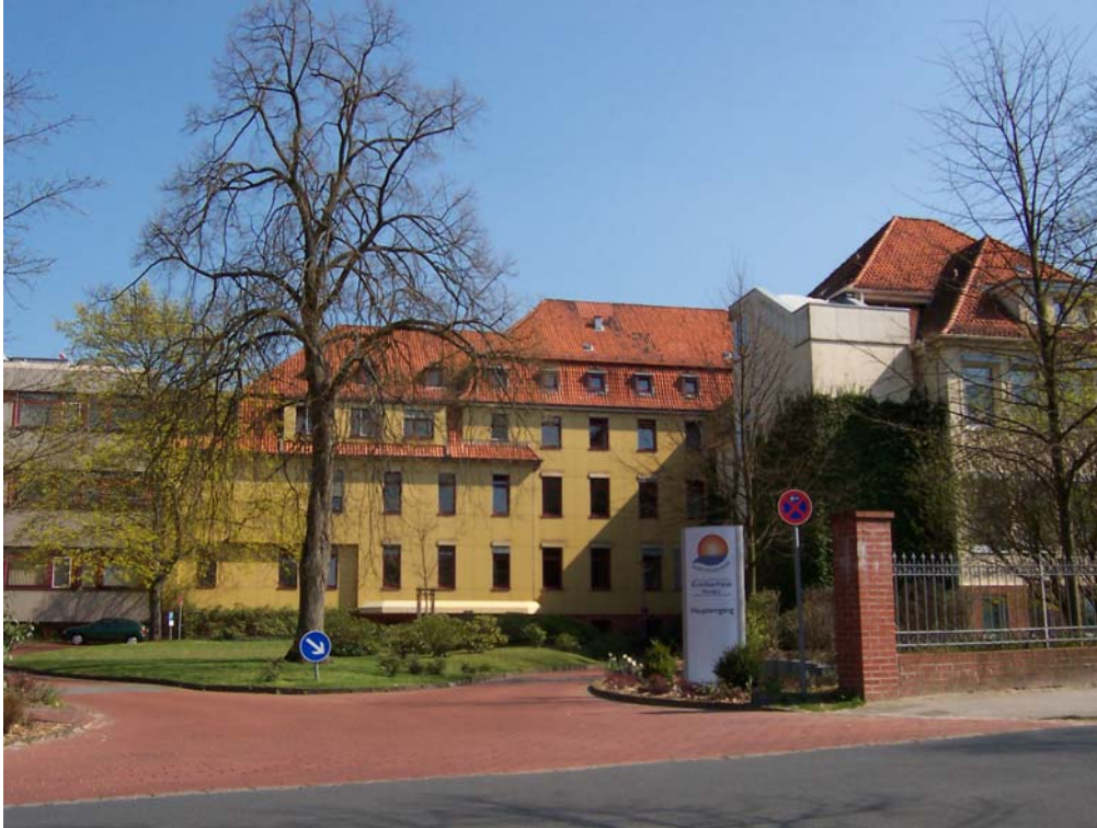
Abbildung: Haupteingang der Aller-Weser-Klinik Verden - Nordseite
