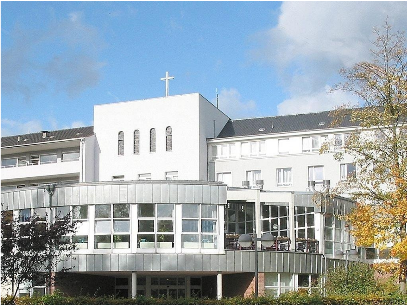
Abbildung: Orthopädische Klinik Volmarstein - Eingangsbereich mit Cafeteria
