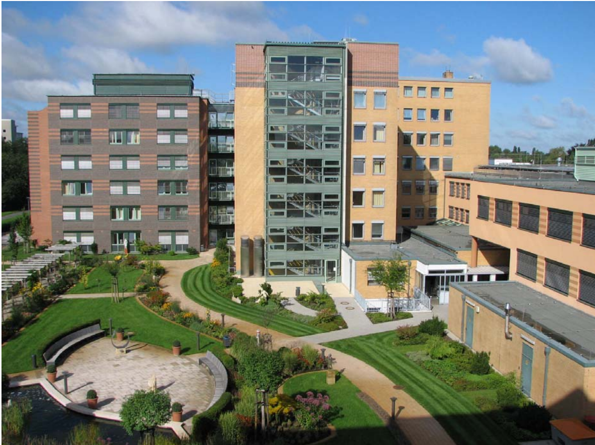
Abb.: Herzogin Elisabeth Hospital Braunschweig, Ausschnitt Garten und Ostfassade
