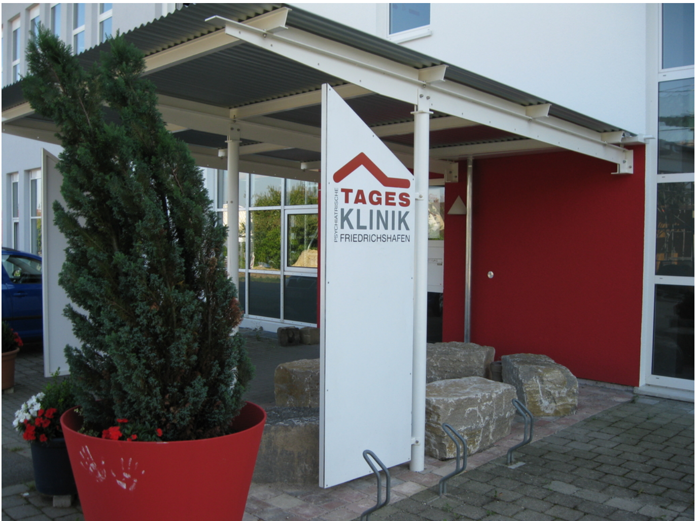
Abbildung: Abbildung: Eingangsbereich der Tagesklinik. Die Tagesklinik befindet sich am nördlichen Rand von Friedrichshafen, gut an das öffentliche Verkehrsnetz angebunden, 800 m 2 Nutzfläche
