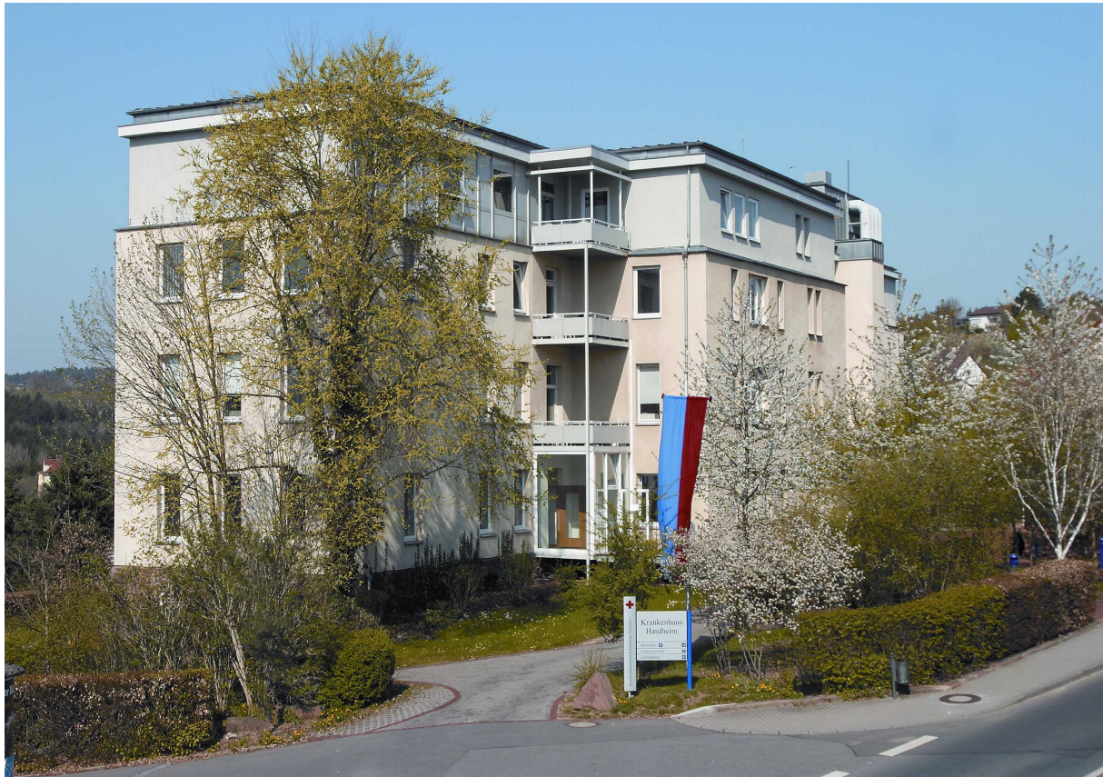
Abbildung des Krankenhaus Hardheim
